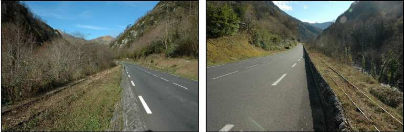
Zone de jumelage entre la voie ferrée, la RN 134 et le gave d'Aspe
