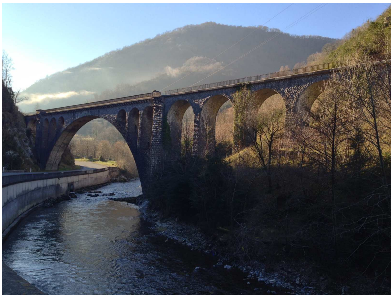
Le viaduc d'Escot franchissant le gave d'Aspe et la RN 134
